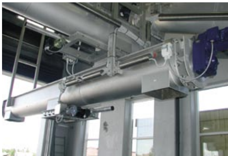
Komplet transportanlæg til slam monteret med automatiske skydespjælde.
