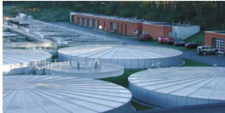
Overdækning på primærtanke minimerer lugtgenerne
