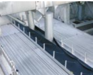
Sådan er overdækningen på sandfanget lavet i Roskilde.
