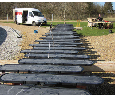
Klargøring af pladebeluftere Stjernholm/Supratec type MF1100 hos mejericenter Arla i Nr. Vium. Højere effektivitet i forhold til diffusere reducerer renseanlæggets udgifter til energi med 20 pct. eller 36.000 kWh om måneden.
